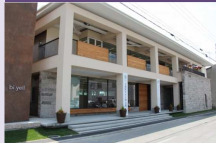
丘のまち交流館「ビ・エール」整備後外観 (H27.6月)
