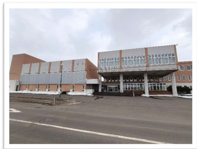
【美瑛町町民センター】
