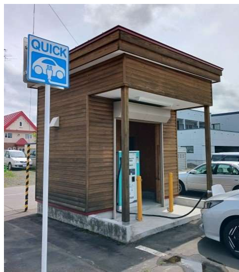
道の駅びえい「丘のくら」に設置しているEV充電設備
