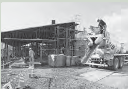
宿泊施設の工事の様子
